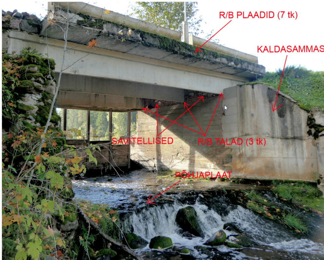
Foto 7. Liigveelaskme ja silla konstruktsioonid (15.11.2024)
